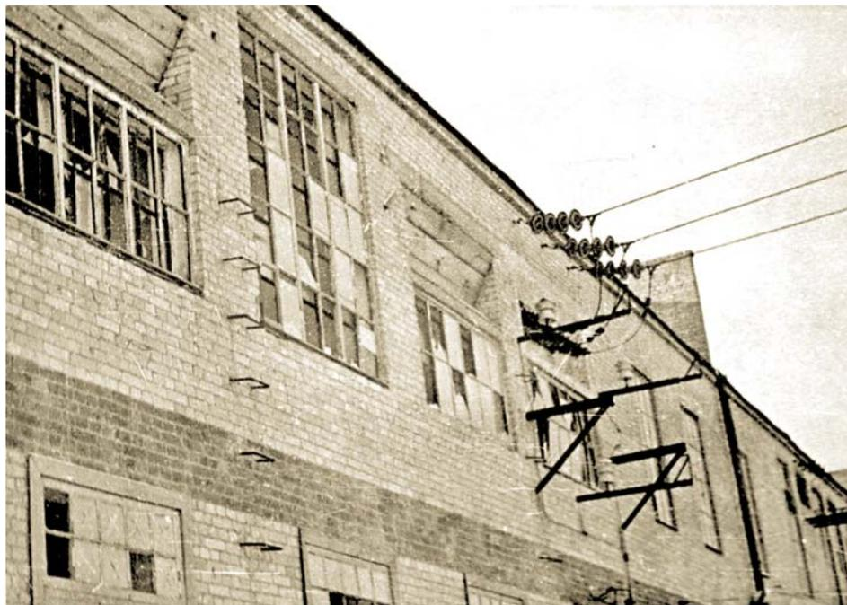
Подстанция 35 кВ «Щёкинская» после разрыва авиабомбы малого калибра внутри подстанции
